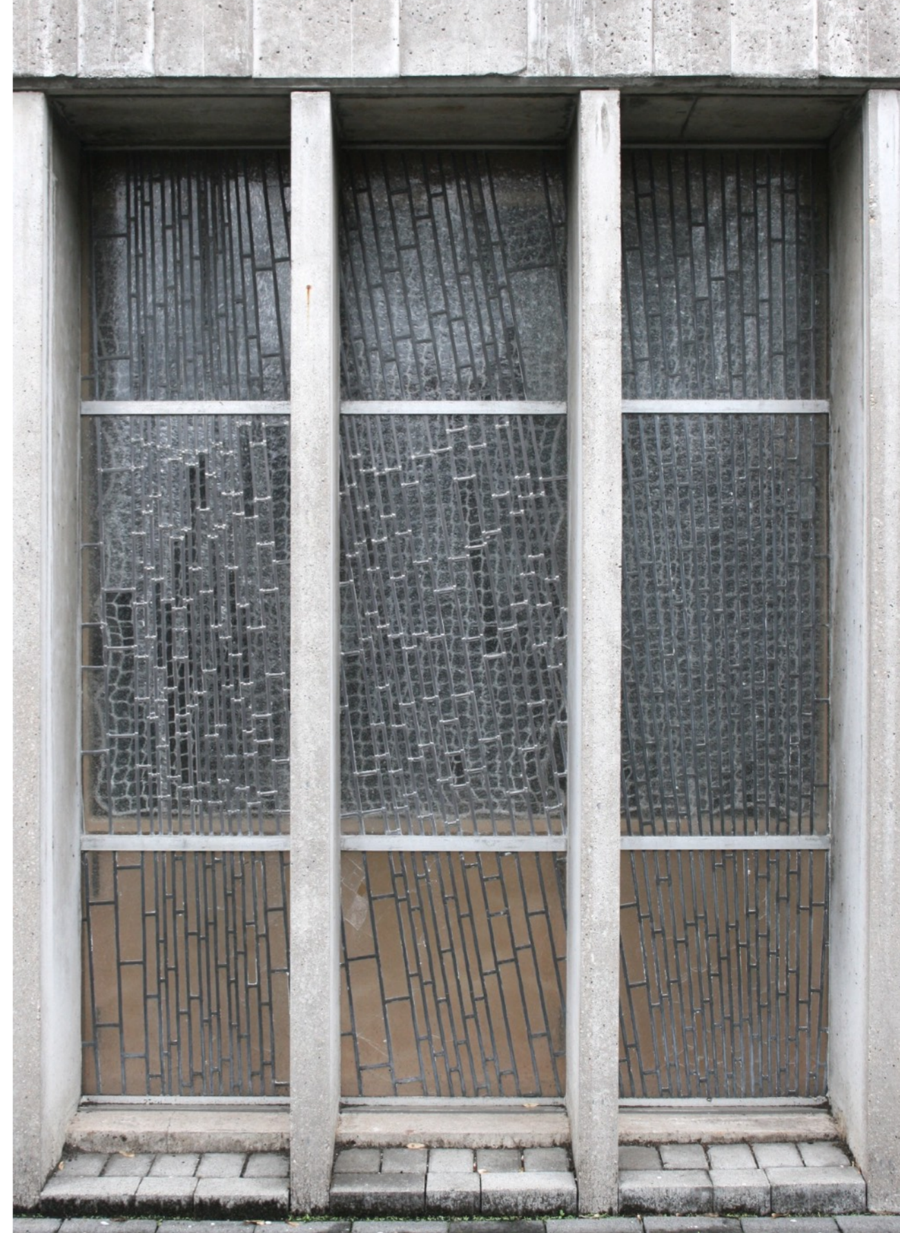
Fenster in der Fassade
