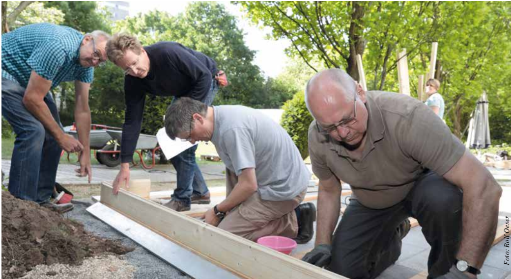
Eine Gartenhütte entsteht. Mitarbeitende der Bauabteilung des ERV beim Social Day im Martha-Haus. Klaus Weilmünster, Thomas Kress, Steffen Theil und Hans-Ernst Rüdiger (v.r.n.l.)
